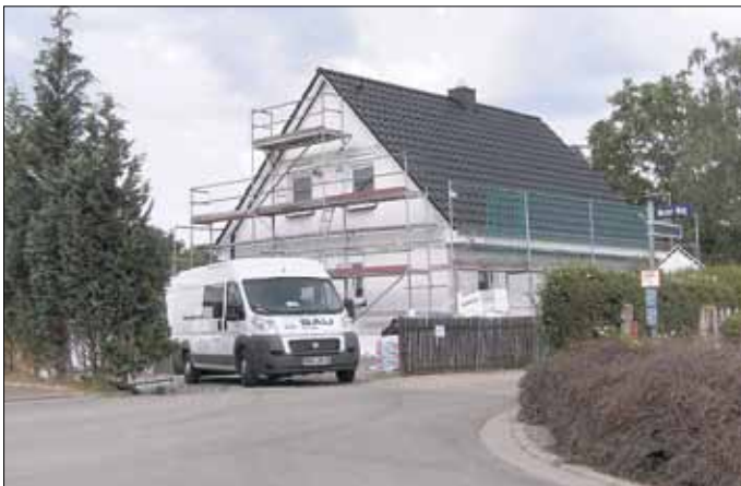
Neubau am Kalten Feld
