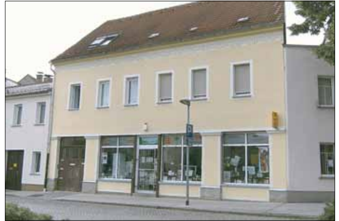
Die Fassade in der Altenburger Straße ist fertig
