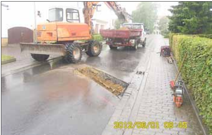
Kanalarbeiten in der R.-Bahrdt-Straße
