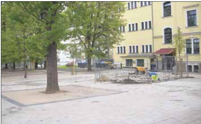
Schulhofgestaltung an der Mittelschule
