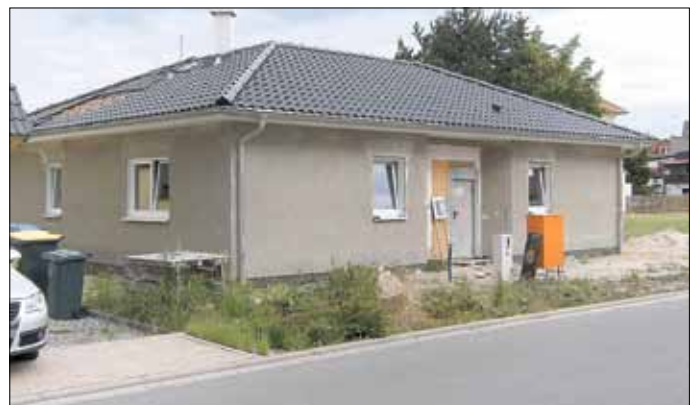
Neubau am Neuen Weg
