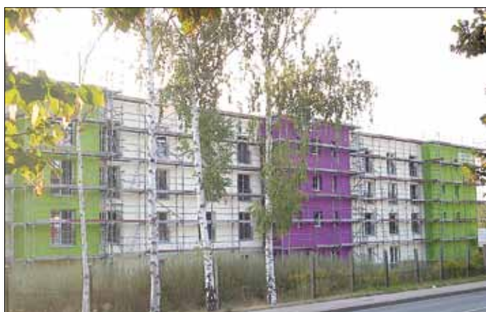
Der Pflegeheim-Neubau auf dem ehemaligen Bella-Gelände bekommt Farbe
