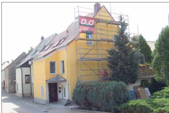
Fassadenarbeiten in der Schützenstraße
