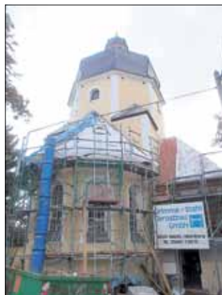
Dachsanierung Kirche Audi-gast
