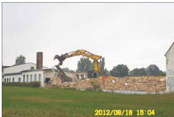
Abbruch der ehemaligen „Plasta“
