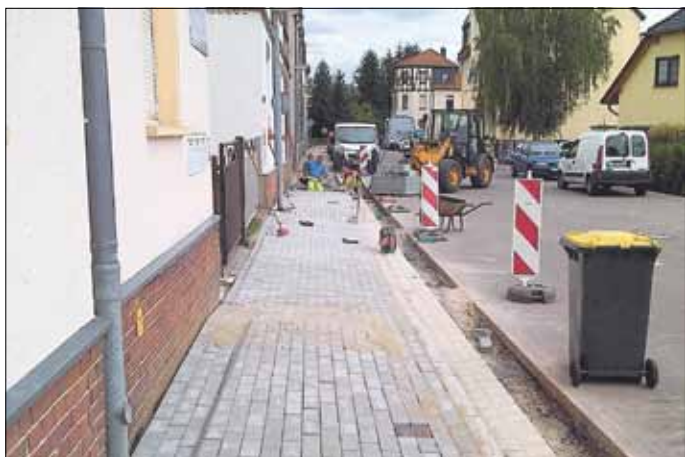
Gehwegsanierung in der Oststraße
