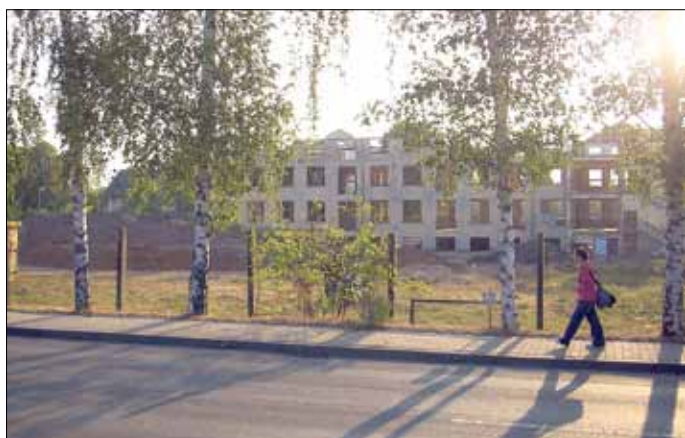
Nun schon komplett entkernt und ohne Dach
