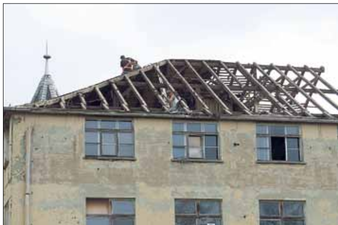
Am alten Bella-Hauptgebäude wird das Dach abgebaut
