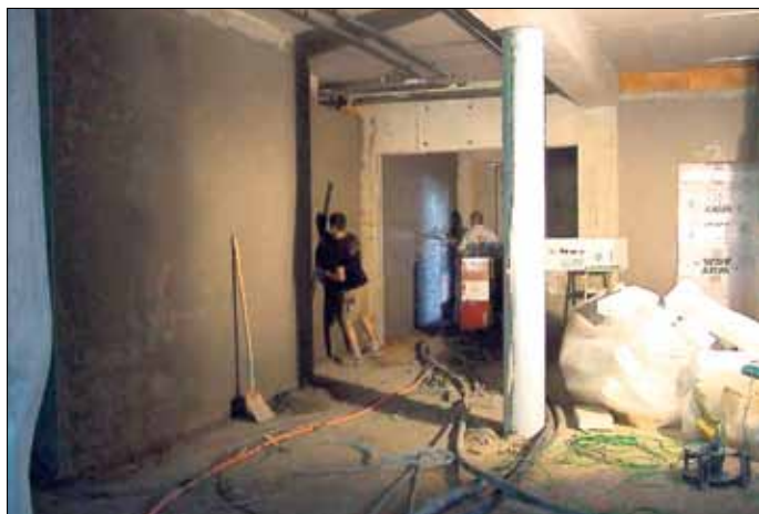
Innenausbau im neuen Pflegeheim
