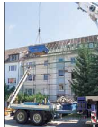
Dacharbeiten in der Käferhainer Straße
