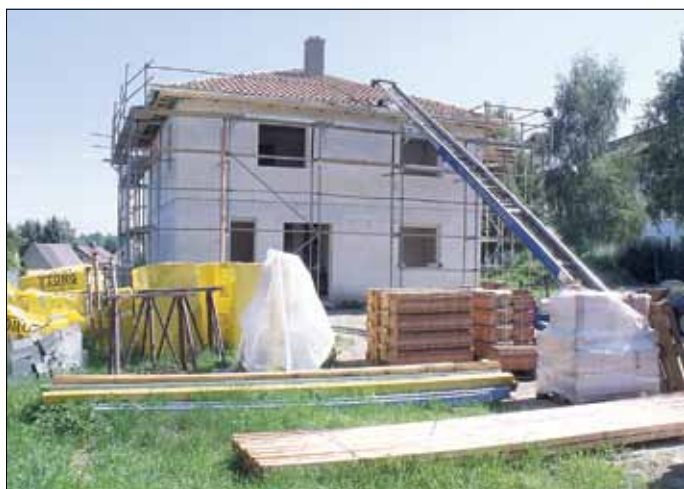
Ein Neubau in der Droßdorfer Straße
