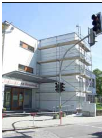
Fassadenarbeiten am Hort
