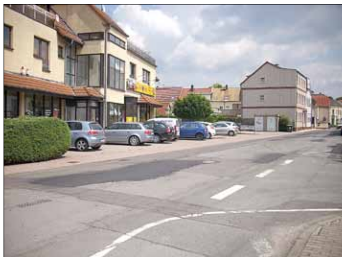
Die Richard-Wagner-Straße wurde geflickt
