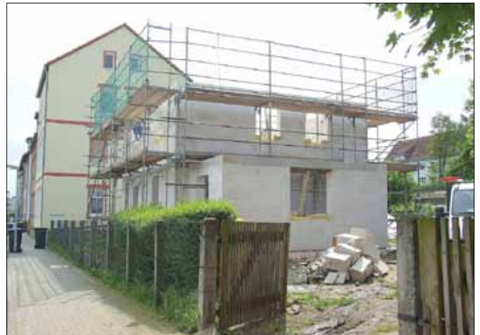
Auch in der Schletterstraße entsteht ein Eigenheim
