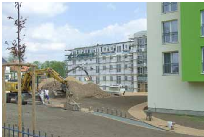
Die Arbeiten am ehemaligen BELLA-Hauptgebäude gehen schnell voran
