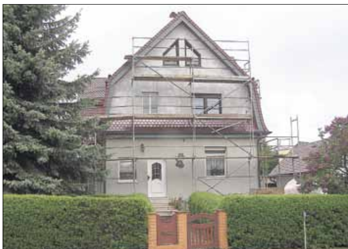
Fassadenarbeiten in Großpriesligk
