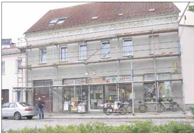
Fassadenarbeiten in der Altenburger Straße
