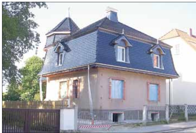
An der Villa in der Friedrich-Ebert-Straße sind die Gerüste gefallen
