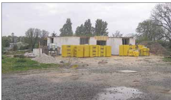
Ein Neubau entsteht in Wischstauden
